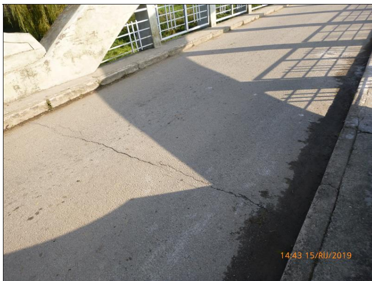
Trhlina ve vozovce v prostoru mostního závěru na opěře 1.
